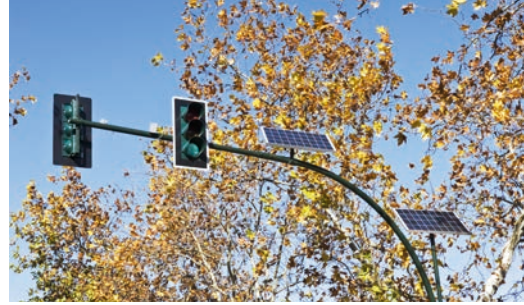
Resim 3.13 Güneş enerjisi ile çalışan trafik lambası
